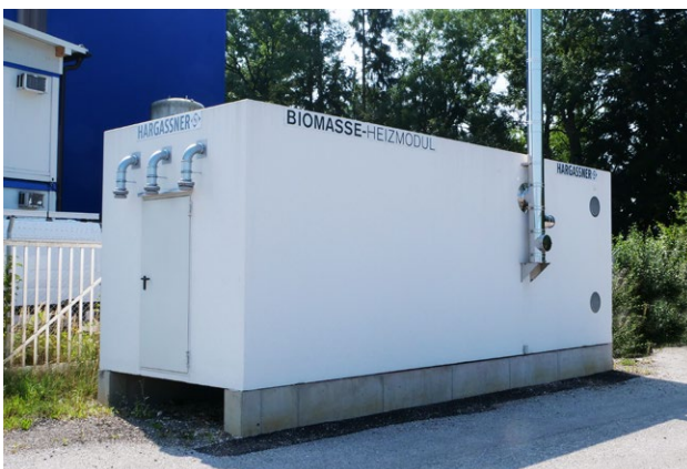
Einstock-Heizmodul 120 kW Pellets, Gewerbeobjekt
